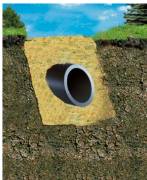
Układanie rur w tradycyjny sposób z obsypką piaszczystą
